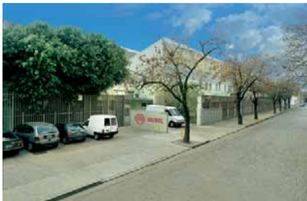
Industrial Plant in Buenos Aires (150.000 sq. ft.). Planta Industrial de 15.000 m 2 en Buenos Aires.
