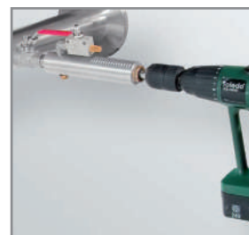
Perforación bajo presión con el dispositivo de per- foración de CS
